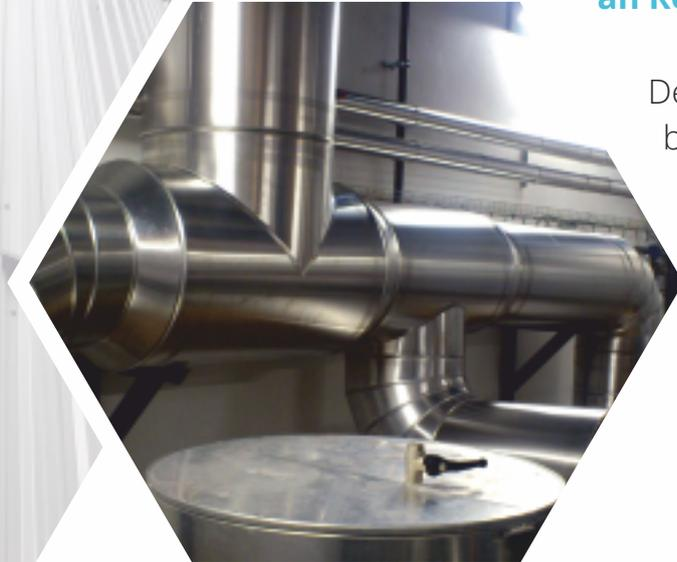
Der Arbeitsumfang bei diesem Projekt bestand darin, Rohrleitungen und Tanks mit Armaflex Dämmstoffen und Paroc Steinwolle zu versehen.
